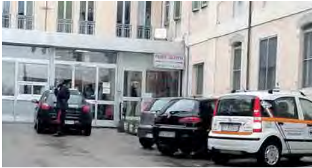
OSIMO L'ingresso dell'ospedale Ss. Benvenuto e Rocco
